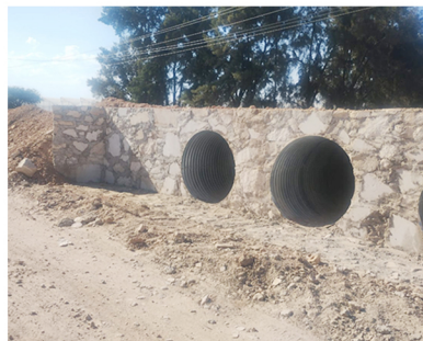
Alcantarilla vial en el camino de acceso a Pixtiopan.
