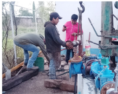
Mantenimiento de pozo profundo en San Juan Ixcaquixtla.
